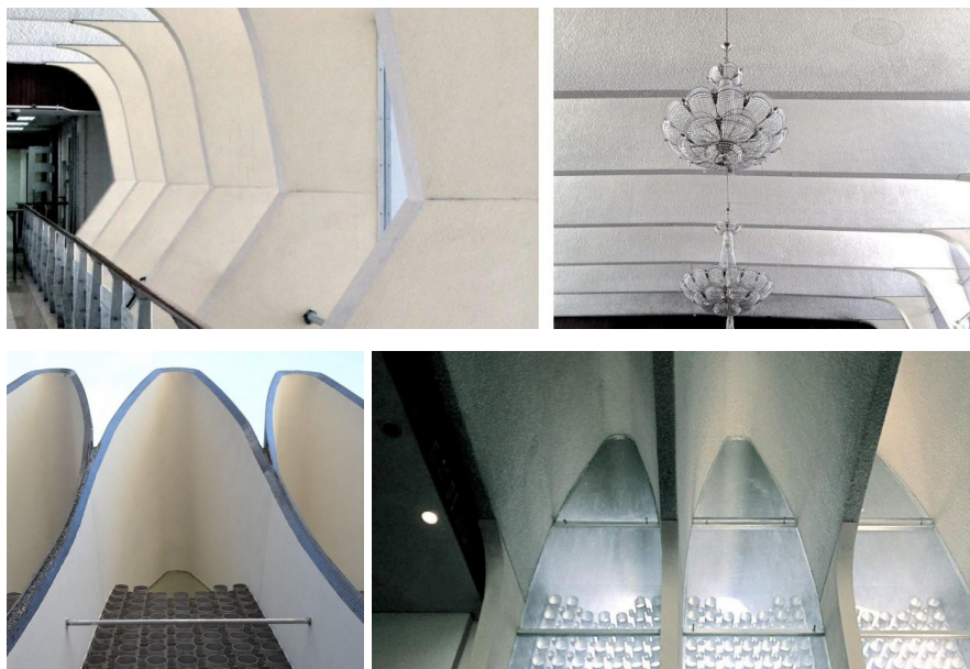
Gambar 7.14 Penggunaan konkrit bertetulang untuk membina struktur bangunan dan bumbung berkubah (Ng et. al, 2016)
