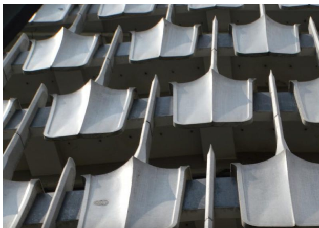
Gambar 3.15 Alat pelindung matahari konkrit pada fasad bangunan Wisma Angkasapuri (Wong, 2014)
