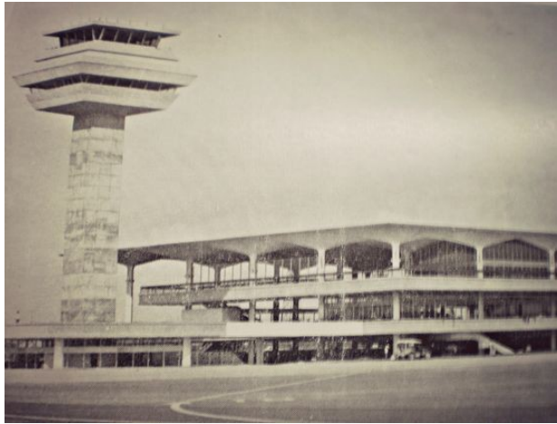
Gambar 3.32 Penggunaan struktur tiang cendawan di Lapangan Terbang Subang (Lim, 2010)
