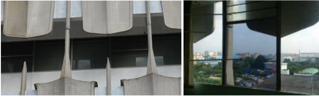
Gambar 7.8 Fasad tingkap bereben di bangunan pentadbiran (Wong et. al, 2014)
