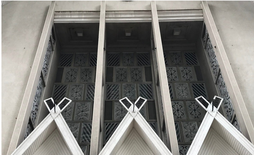
Gambar 5.19 Skrin konkrit pracetak bermotifkan bunga di pintu hadapan Muzium Negara
