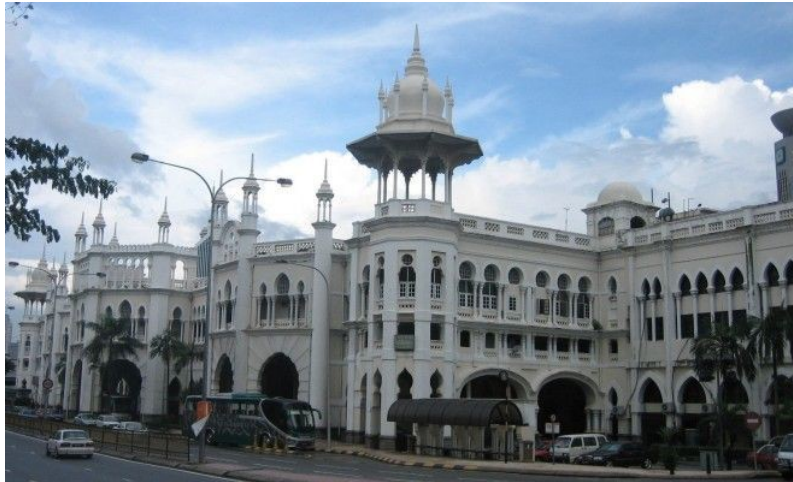
Gambar 4.5 Bangunan Stesen Keretapi Lama (Thia et. al, 2017)
