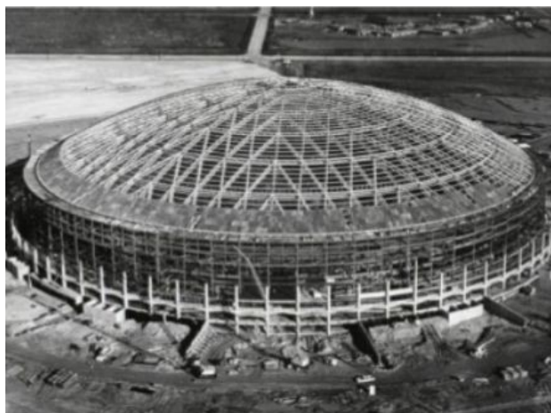
Gambar 3.17 AstroDome - struktur bumbung besi Stadium Negara semasa tempoh pembinaan (Khor et. al, 2015)
