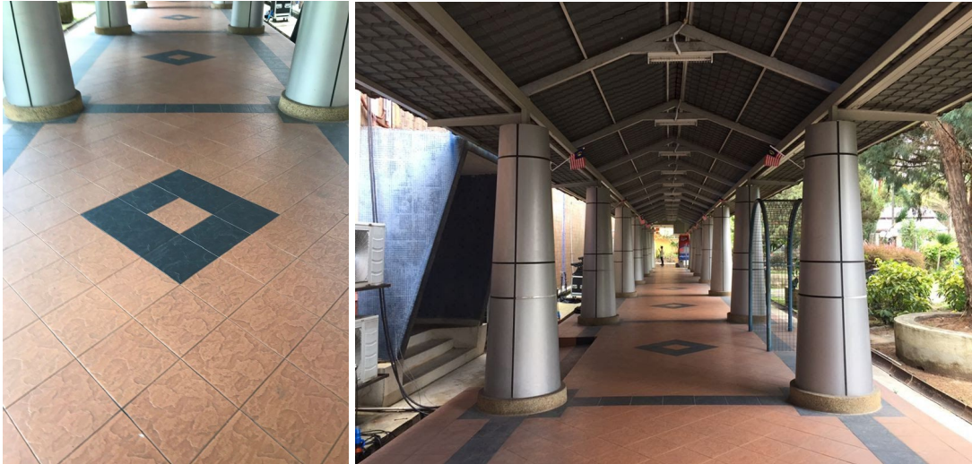
Gambar 7.19 Jubin terazo kasar digunakan untuk bahagian luar bangunan
