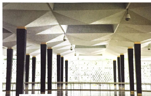
Gambar 3.34 Penggunaan struktur tiang cendawan di Masjid Negara (Lim, 2010)
