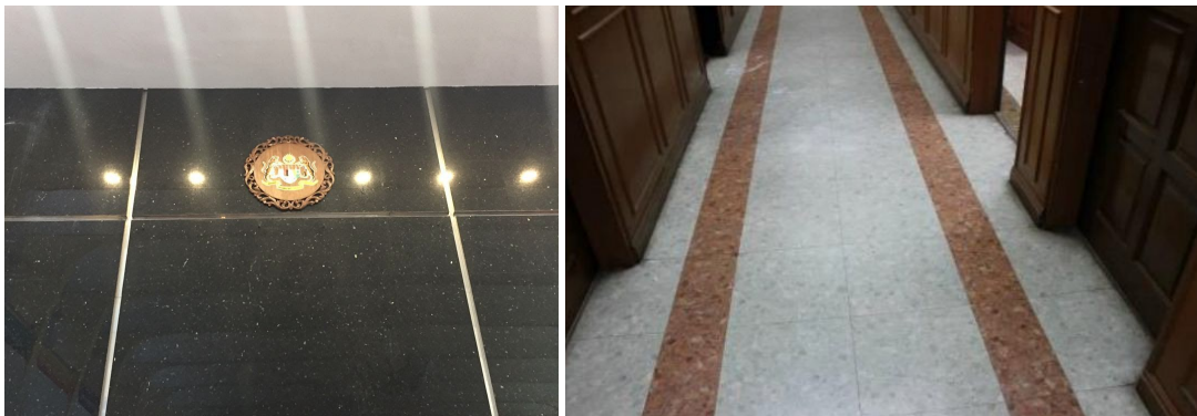
Gambar 7.20 Jubin terazo berkaca digunakan untuk kemasan dinding dan lantai di ruang dalam bangunan (Lee et. al, 2016)
