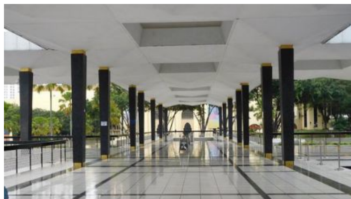
Gambar 4.21 Bukaan pada beranda untuk pengudaraan
