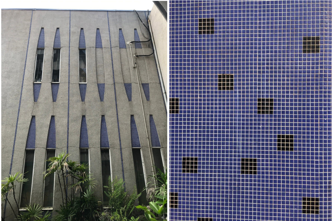
Gambar 7.18 Jubin seramik kaca digunakan untuk kemasan dinding
