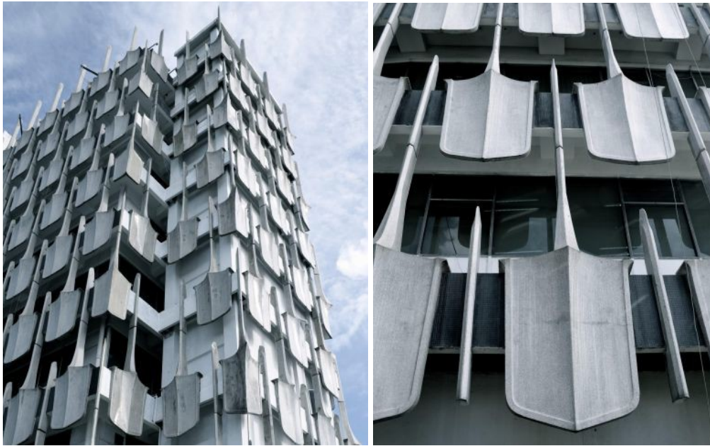
Gambar 7.15 Brise soleil pada fasad bangunan pentadbiran Wisma Angkasapuri (Pua et. al, 2014)
