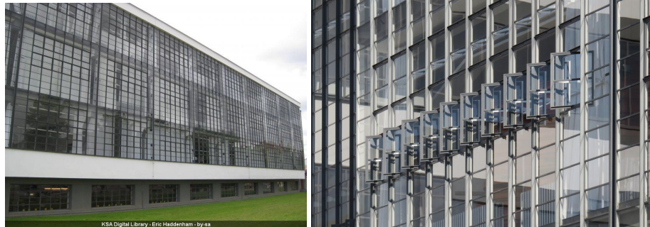
Gambar 2.5 Dinding tirai (kiri) dan fasad kaca (kanan) pada bangunan Bauhaus , Dessau (Ayon, 2016)
