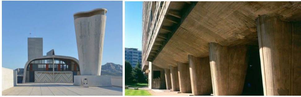
Gambar 2.23 Bahagian bumbung (kiri) dan pandangan hadapan (kanan) Unite d'Habitation di Marseille (Hopkins, 2014)
