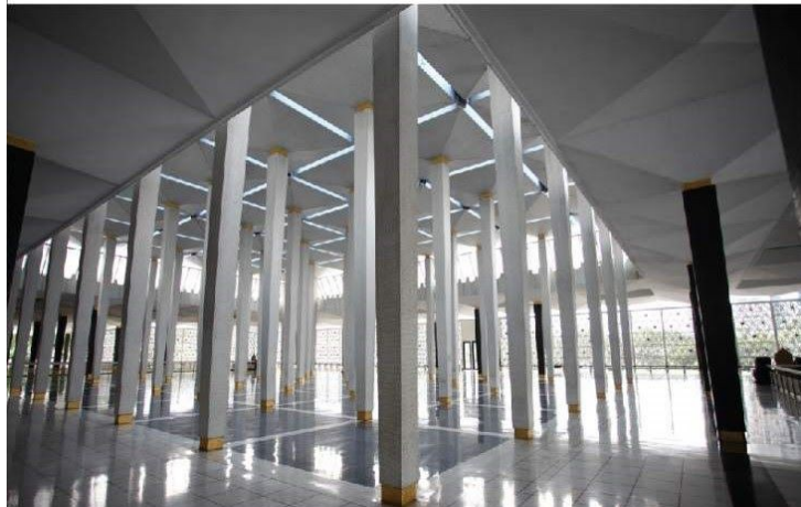
Gambar 4.28 Jubin terazo pada lantai Masjid Negara (Azim, 2015)
