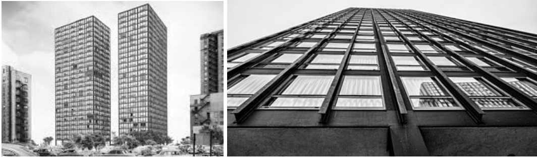
Gambar 1.9 860-880 Lakeshore Drive di Chicago (kiri) dan penggunaan seni bina “skin and bone” (kanan) (Rochkind, 2017)
