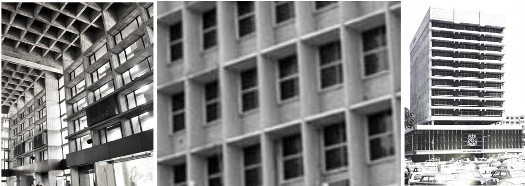
Gambar 3.25 Dari kiri: Fasad bangunan Dewan Tunku Canselor, UM; bangunan Koperasi Polis; dan Standard Chartered Bank (Lim, 2010)
