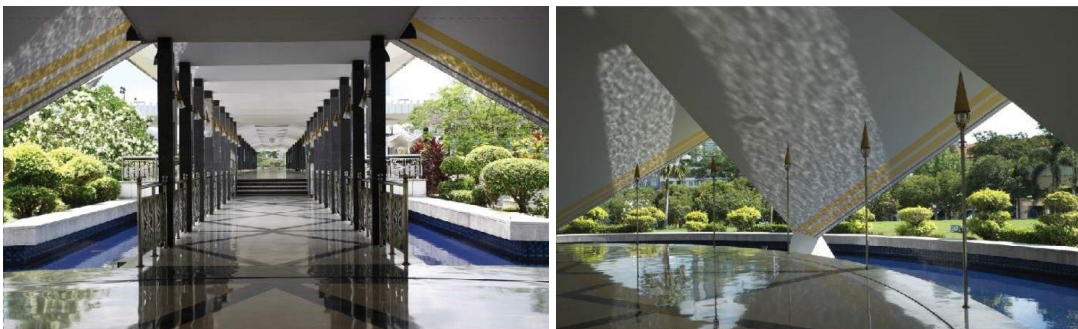
Gambar 4.27 Kemasan marmar Itali pada lantai Masjid Negara (Azim, 2015)
