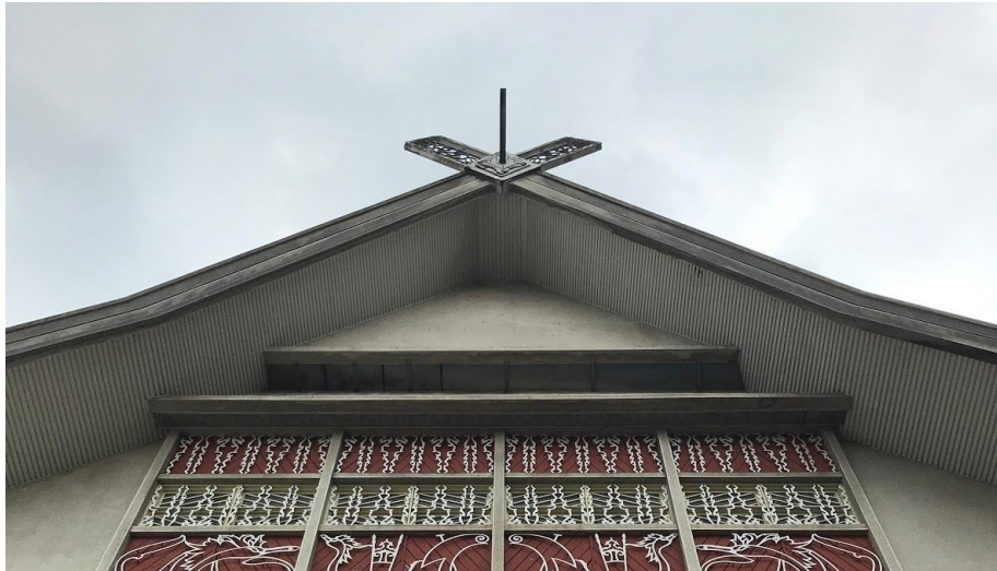
Gambar 5.22 Silang gunting di bumbung Muzium Negara
