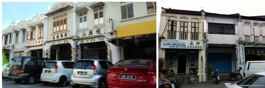
Gambar 3.1 Rumah kedai lama Melaka (kiri) (Sabrina, 2018); dan rumah kedai lama Pulau Pinang (kanan) (Salleh, 2012)
