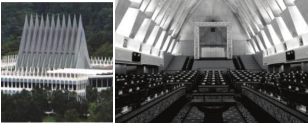
Gambar 3.31 Dari kiri : Penggunaan bumbung berlipat pada Dewan Perwakilan di Parlimen Malaysia; dan ruang dalam Dewan Perwakilan (Sarah et.al, 2017)
