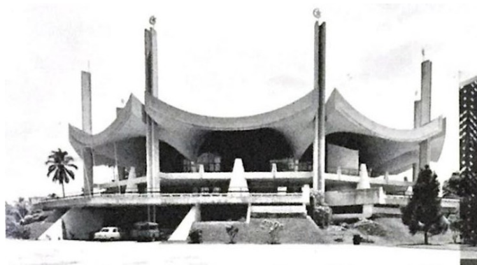
Gambar 3.27 Masjid Persekutuan Negeri Sembilan yang menunjukkan reka bentuk bumbung hyperbolic paraboloid (Lim, 2010)
