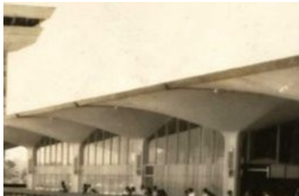
Gambar 3.33 Penggunaan struktur tiang cendawan di Lapangan Terbang Subang (Lim, 2010)
