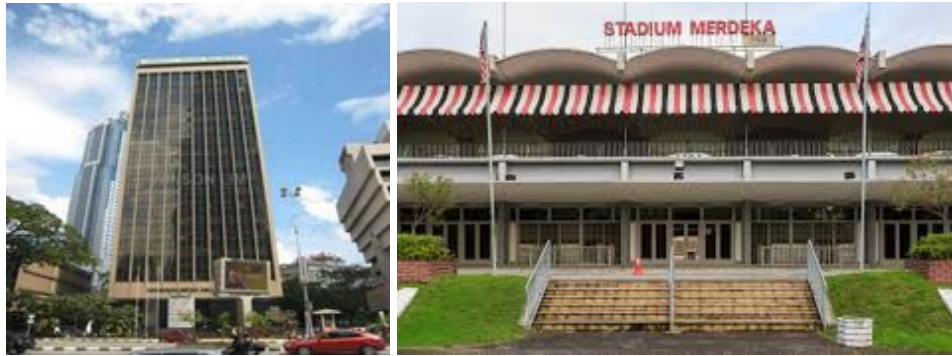
Gambar 3.8 Bangunan Getah Asli (kiri) dan Stadium Merdeka (kanan) (Aranas, 2014)
